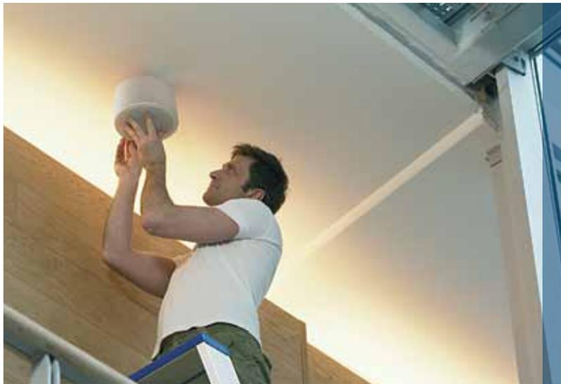
Wenn eine Unterputz-Montage der Lautsprecher nicht möglich ist, z. B. bei Betondecken, wird die Installation durch einen Aufputz-Montagerahmen vereinfacht.
