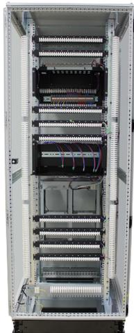
Das BAP-BAS19T3 Grundsystem 19" Typ3 besteht aus dem VdS-zugelassenen Schranktyp Rittal VX-IT (42 HE), einem Grundausbau (Kabel, Träger, Befestigungen zur Aufnahme der Funktionsbaugruppen), der Basisenergieversorgung (Energieversorgungseinheit, Trägereinheit mit Modulträger zur Aufnahme von bis zu 4 Batterieregler-Modulen BCM-0000-B und 230-V-Verteilung) und der MSE3 2040 Trägereinheit Switch.
