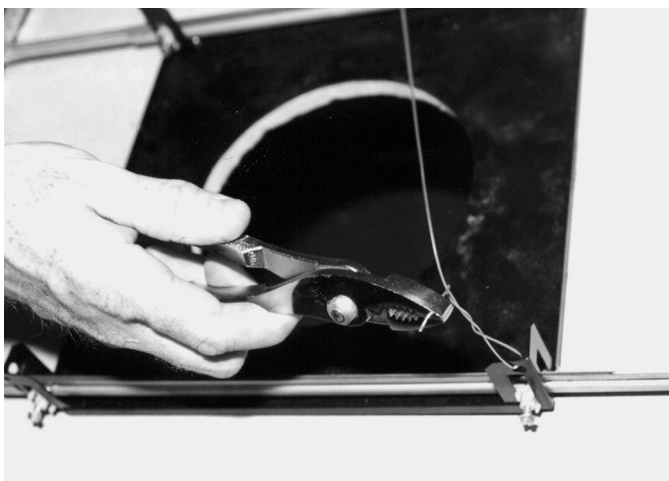
Rysunek 7.4: Zabezpieczanie uchwytu za pomocą linki
