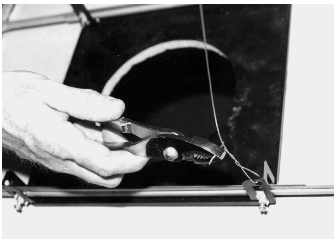
Afbeelding 8.4: Het beugelsysteem bevestigen
